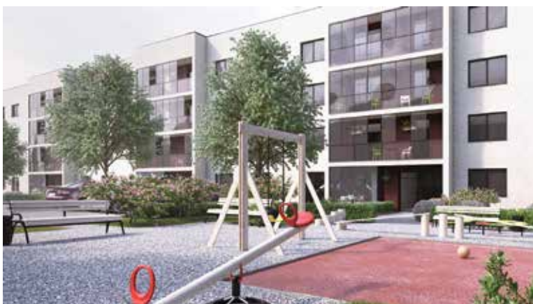
NAUJOJI PILAITĖ, residentiële gebouwen, Litouwen. 201 x Domekt R 200 V. Totaal luchtvolume 50 000 m³/h
