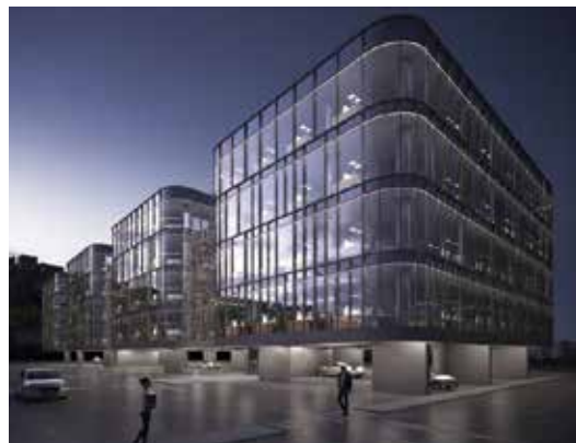
RIVER HALL. Litouwen. 32 x Verso R 2500. Totaal luchtvolume 80 000 m³/h
